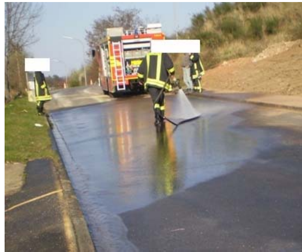
Nachspülen einer mit Tensid-Wassergemisch nachbehandelten Fahrbahn!!! →Umweltschaden (Boden, Grundwasser....)
